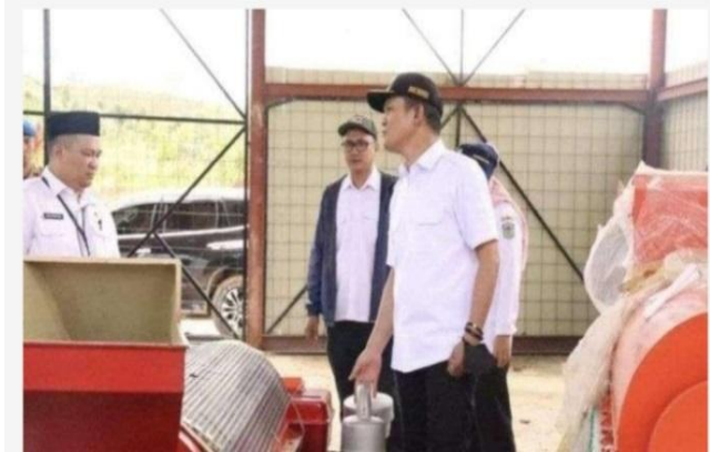
Gambar 7. Wawako Antos meninjau hasil pembangunan 16 TPS 3R
