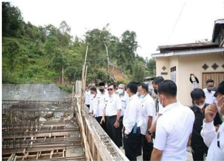
Gambar 5. Pemerintah Kota Sungai Penuh Meninjau Pembangunan Jembatan di Kec. Sungai Bungkal
