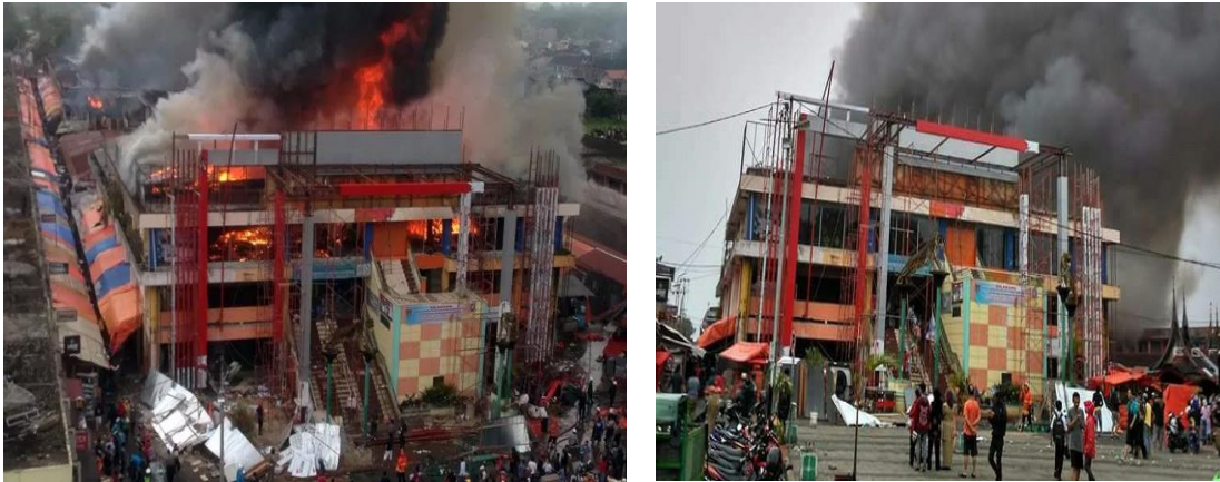
Gambar 1. Kebakaran Yang Terjadi Di Pasa Ateh Bukittinggi Tahun 2017
