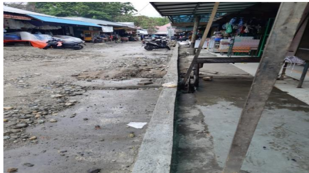
Gambar 3 : Perbaikan Luar Pasar
