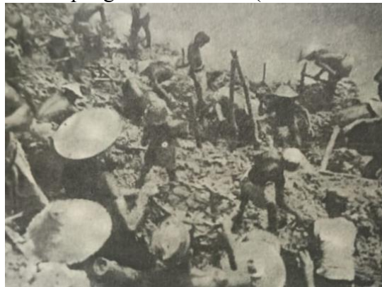
Gambar 2. Proses pembuatan tanggul Neyama
